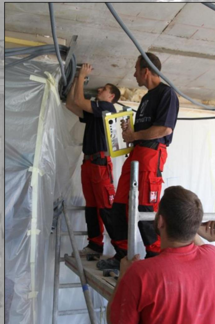
Cette dalle en béton armé de 6 m de portée (par 12 m dans le sens transversal) était sous ferrailée. La déformation de la dalle était telle que seule un renforcement par lamelles carbone précontraintes permettait de reprendre correctement les efforts. Nous avons posé 2 lamelles précontraintes et 80ml de lamelles carbone de répartition.
