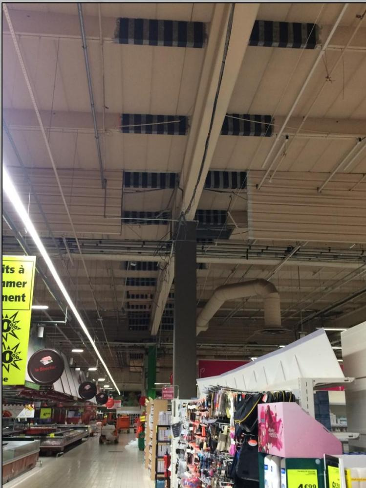
Renfort par Tissu de Fibre Carbone dans le magasin.
