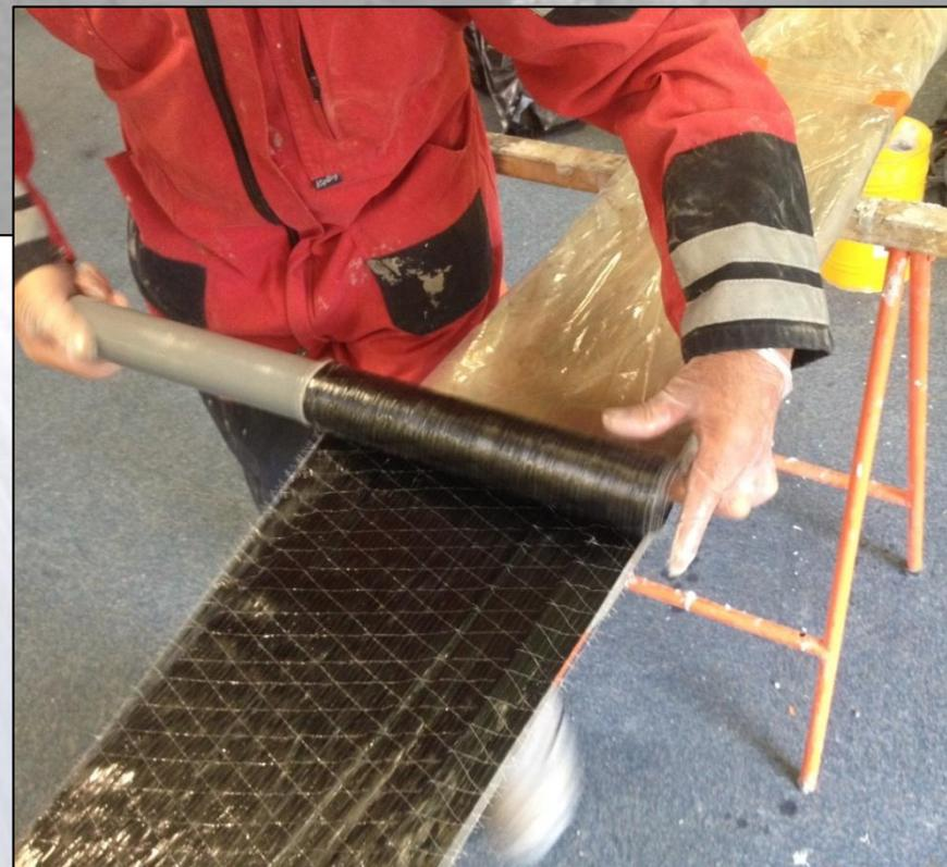
Préparation du composite de treillis de fibre carbone en voie humide.
