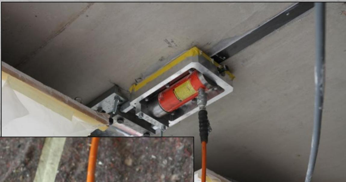
Mise en tension de la lamelle par vérinage.
