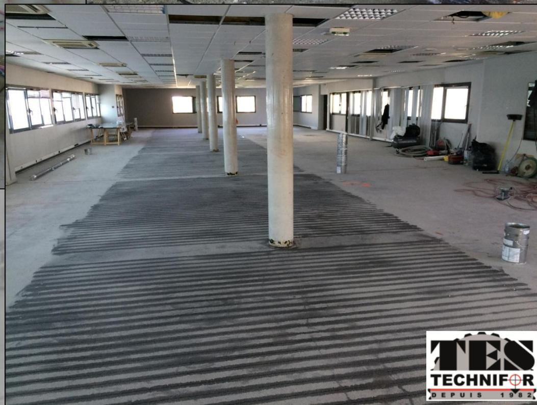
Réalisation de 17 000 ml de sciage au sol pour la pose de lamelle carbone engravée. Réparation de 6500m<sup>2</sup> de bureaux sur le parc de bâtiment « le Millénaire » à Toulouse Blagnac.
