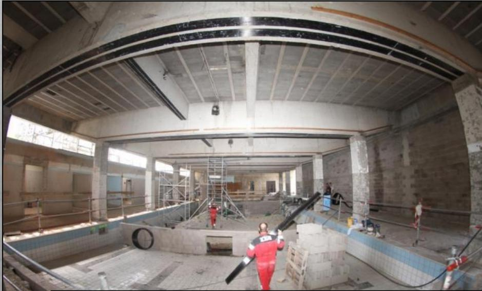
Pour finir, TES-TECHNIFOR a procédé à la pose 400 ml de renforcement par lamelles et treillis de fibre carbone.
