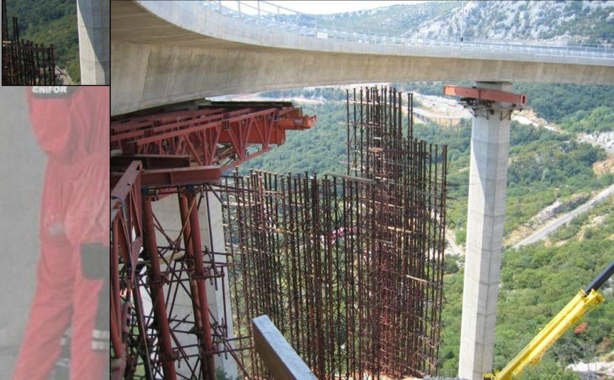
Renforcement d'un viaduc autoroutier Bakar à Rijeka (Croatie) par application de renfort carbone précontraint par post tension.
